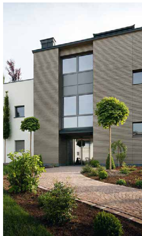
Esempio di costruzione nuova con posa certificata FINSTRAL
